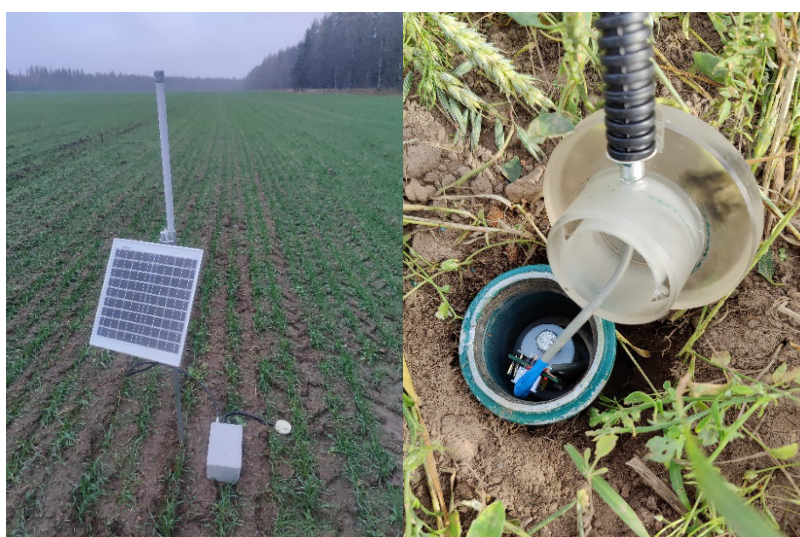
Рис. 32. Сенсорный узел с выдвижной антенной и пятиканальным влагомером полностью подземного размещения
